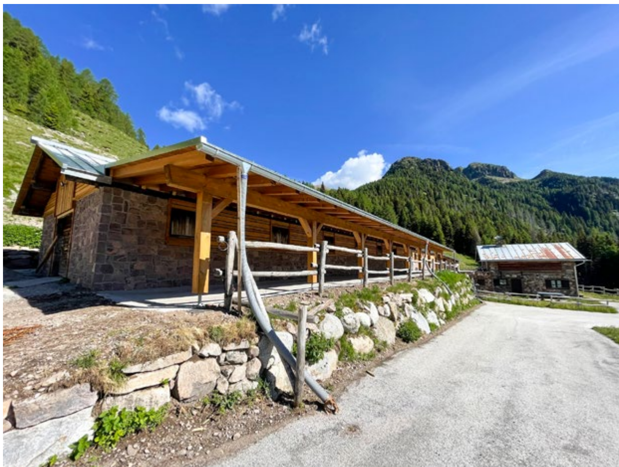
Nuova tettoia Malga Cagnon
