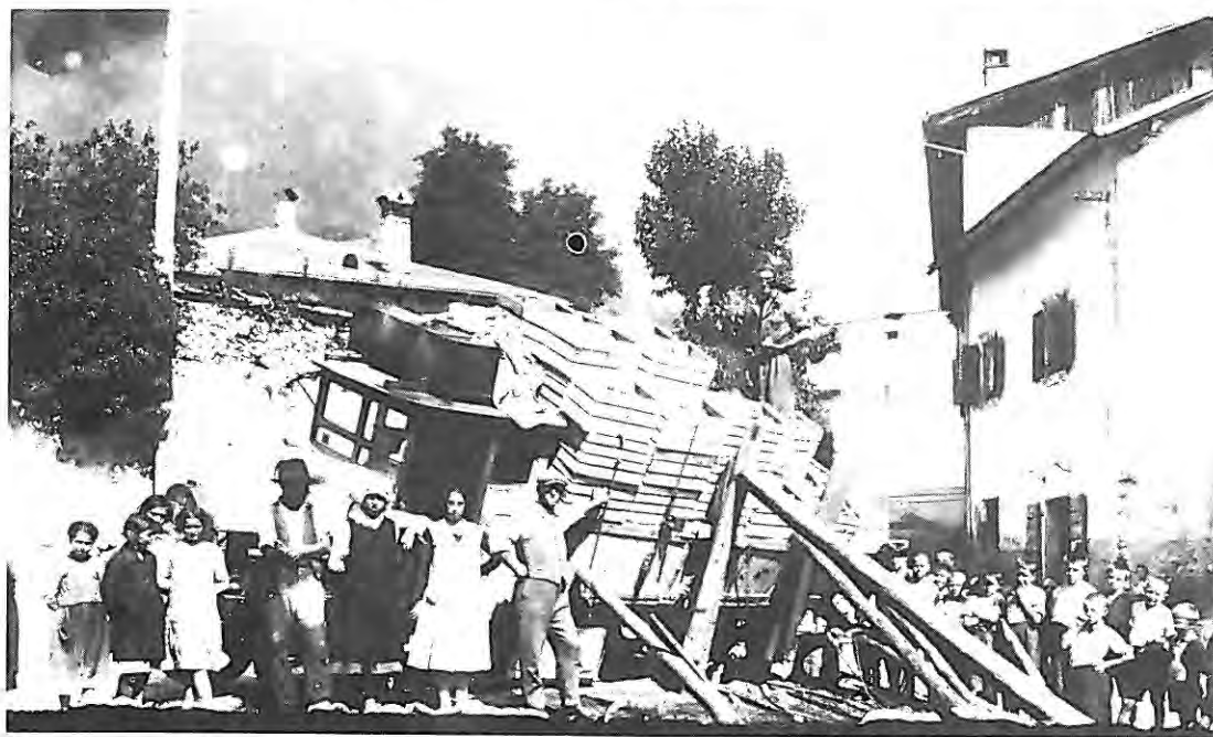
Telve, anni '30 - incidente in Via Rizzoli (a nord della chiesa).
