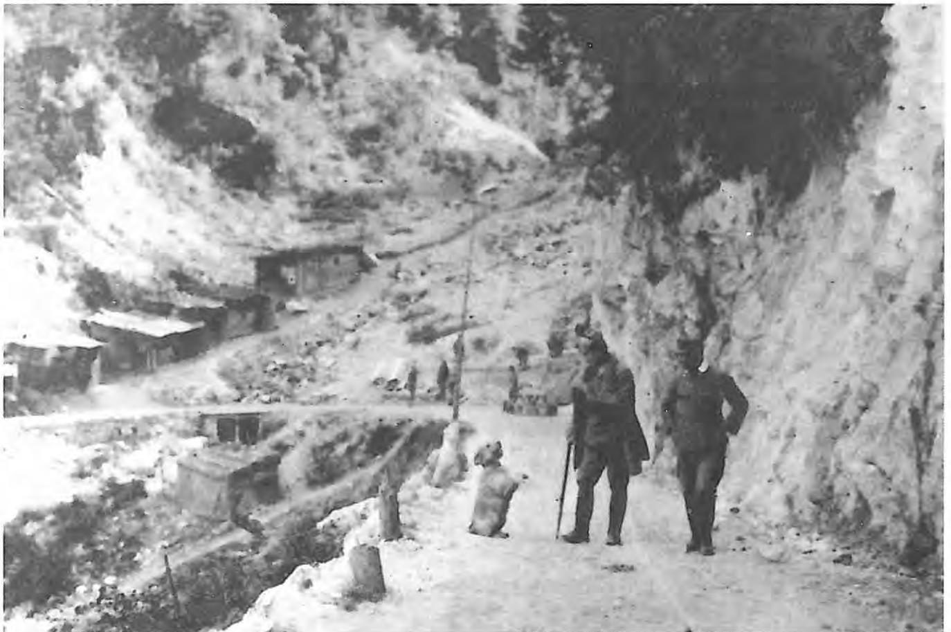
1916. Strada di val Calamento; curvone sul rio Rotegojo
