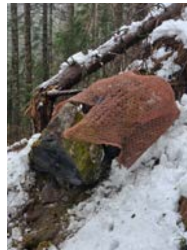
Rete contenitiva posizionata attorno al masso prima di farlo esplodere
