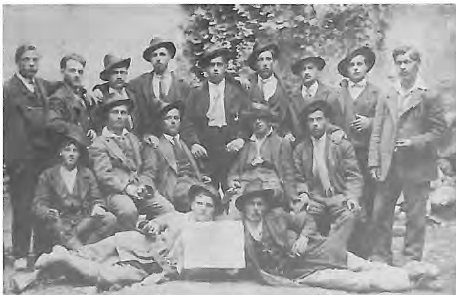
1920 - Inaugurazione del nuovo acquedotto.
