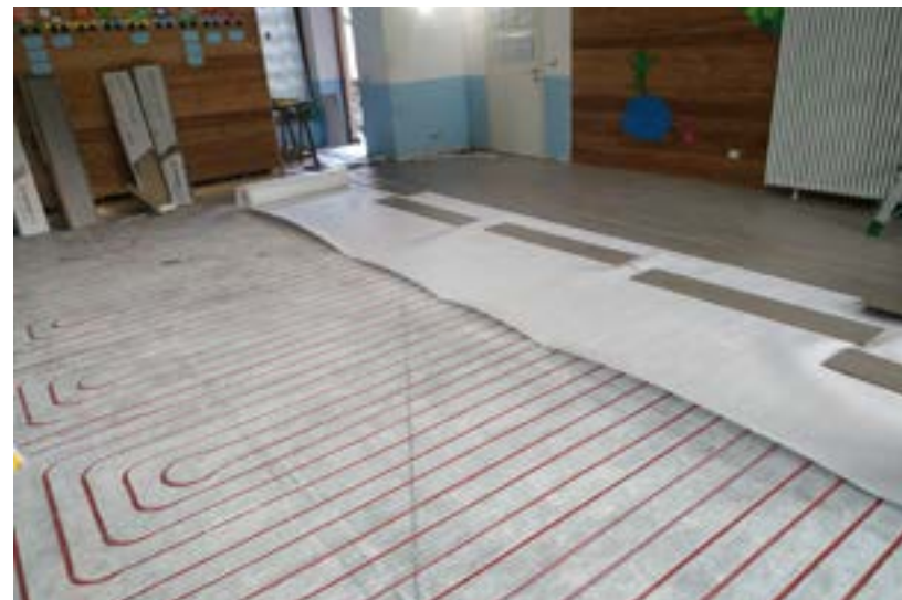
Impianto di riscaldamento a pavimento
