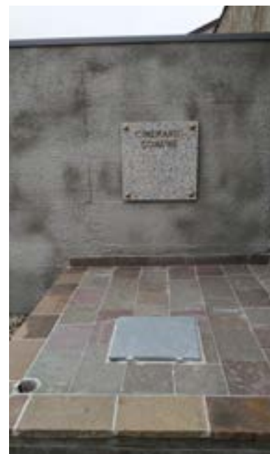
Nuovo cinerario comune
