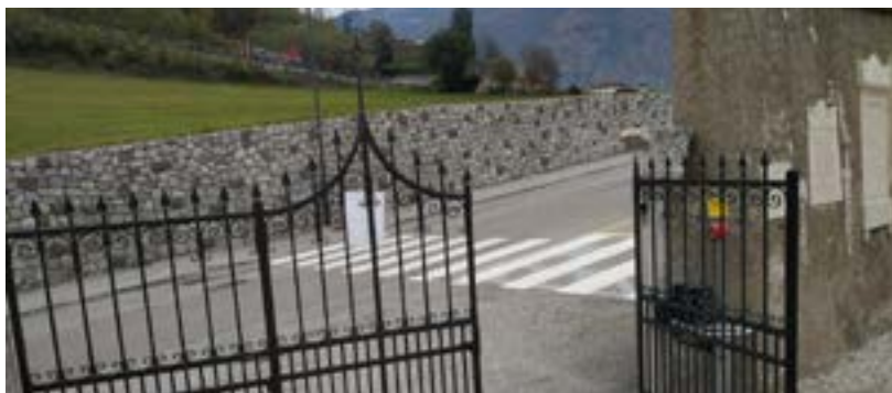
Cancello d'accesso al cimitero elettrificato
