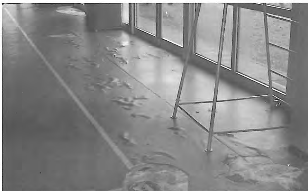
Stato attuale del pavimento della palestra della Scuola Media
