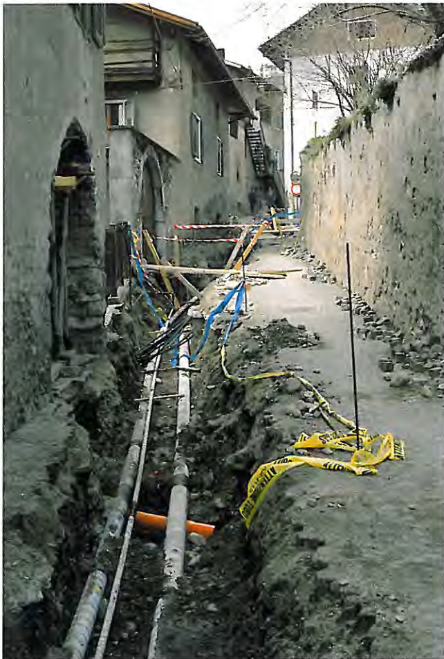
Lavori in Via Grazie
