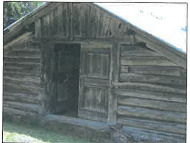
Baita Tipo B - Timpano fronte monte in assi verticali.
