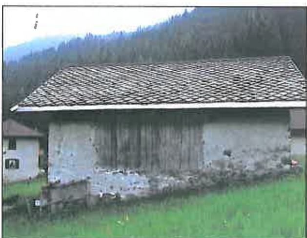
Tamponamento in assi verticali.
