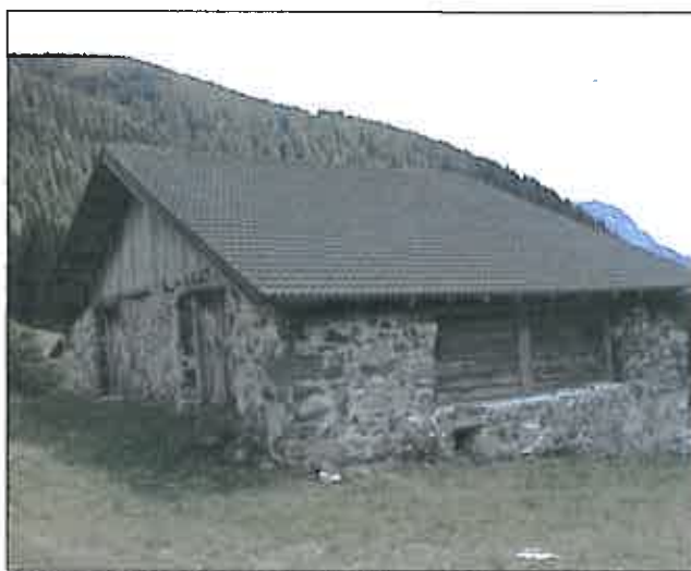
Manto rinnovato in tegole di cemento.
