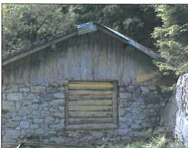
Tamponamento in tronchi orizzontali su telaio.
