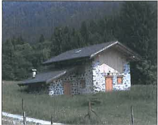
Aggiunta di corpo laterale; rifacimento muratura di pietra, tamponamenti di legno e tetto. Nuovi fori.
