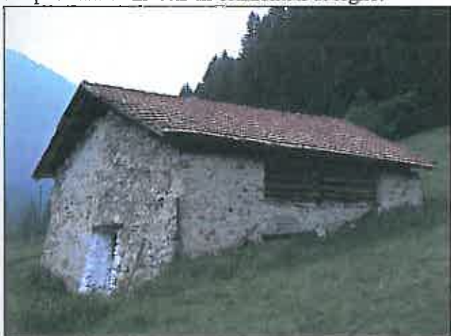
Variante C2 - Struttura a cantonali di pietra con fronte privo di parti lignee
