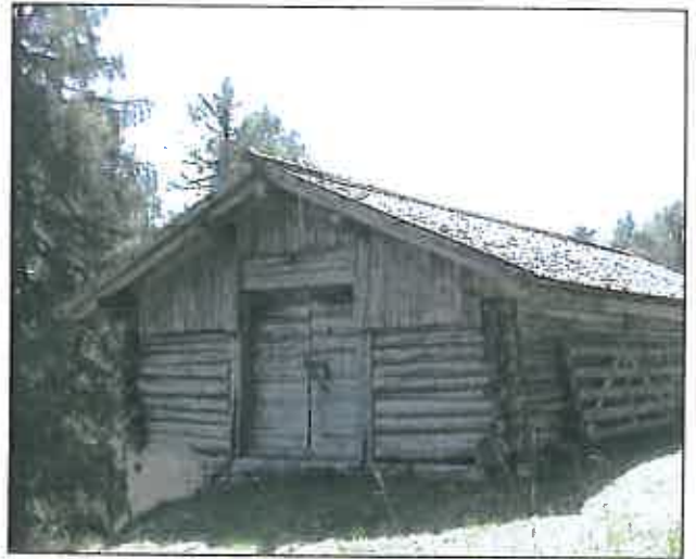
Baita Tipo A - Timpano fronte monte in assi verticali.
