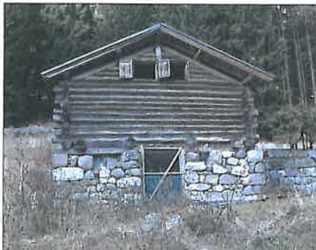
Inserimento di finestre nel timpano in tronchi a incastro sul fronte principale.
