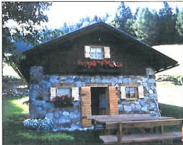
Ampliamento e aggiunta di nuovi fori.
