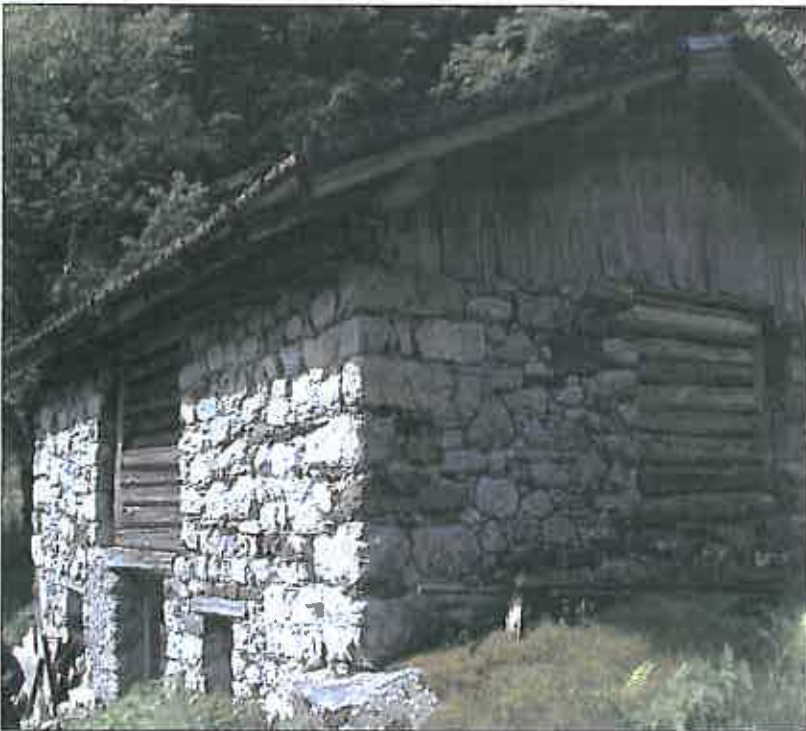
Veduta d'angolo edificio.
