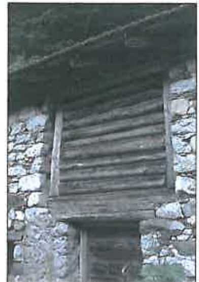
Fronte valle: particolare tamponamento in tronchi di legno orizzontali.
