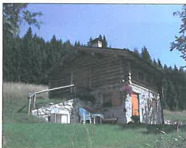
Rifacimento edificio con sostituzione pareti in muratura e in tronchi e aggiunta di nuovi fori.
