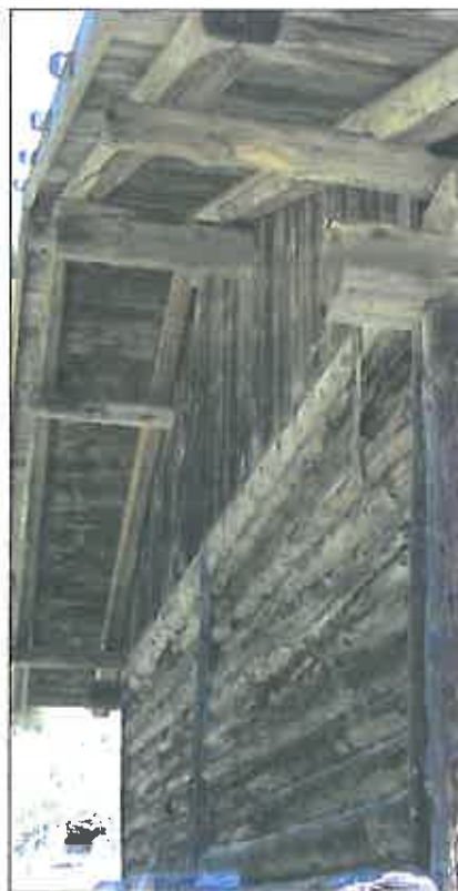
Particolare fronte laterale e tetto.
