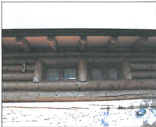
Finestra a nastro nella parete di tronchi a incastro.
