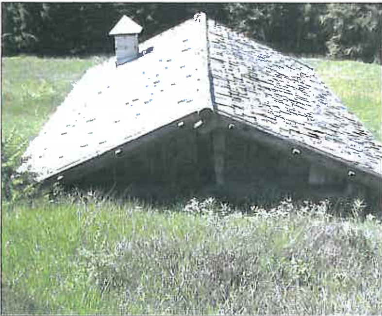
Fronte monte. Il tetto in scandole è stato rifatto con inserimento ex novo del camino.
