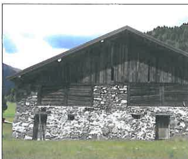
Duplici tamponamento in tronchi di legno orizzontali.
