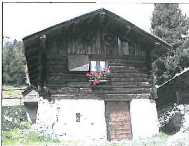
Inserimento di finestra standard sulla parete in tronchi a incastro sul fronte principale.
