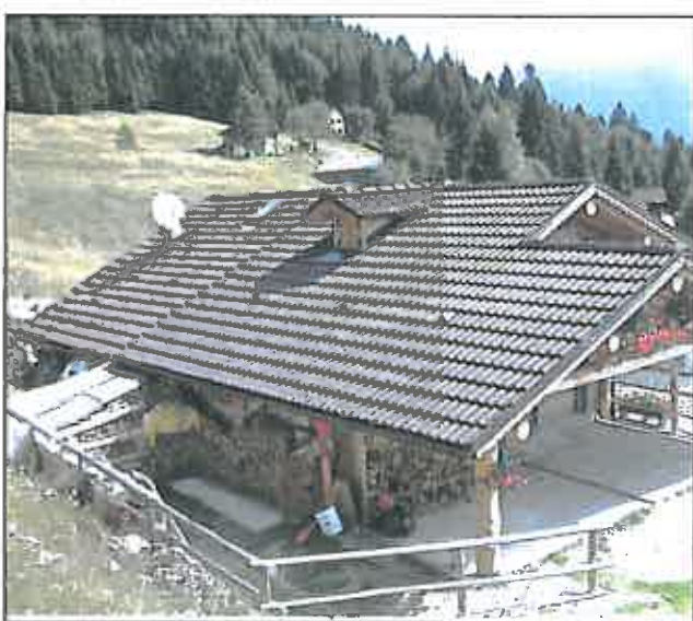
Tetto rifatto con modifica struttura originaria; manto in tegole di cotto.
