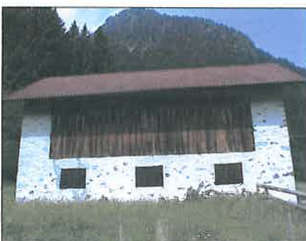
Tamponamento in assi verticali.
