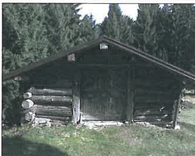
Fronte monte. Fienile con portone di accesso e pareti del fienile e tetto a travi a incastro e terzere.
