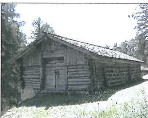
Fronte laterale con accesso al fienile; tetto a capriate e terzere con timpano in assi di legno.
