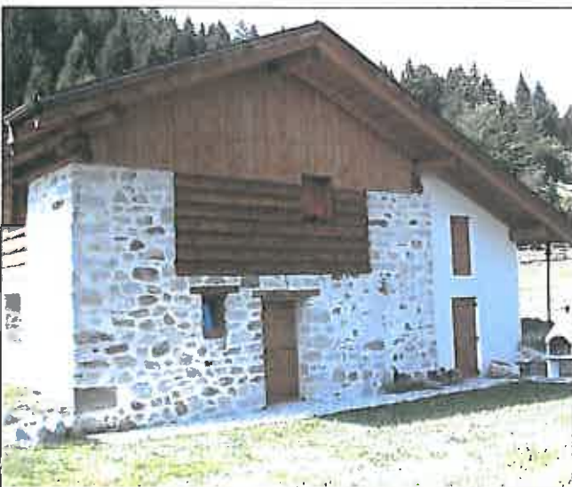
Aggiunta di corpo laterale. Modifica pareti in muratura di pietra, tamponamenti di legno, fori e tetto.
