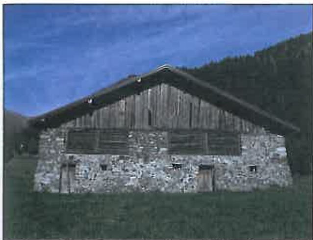
Variante C1- Baita con duplice stalla/fienile; doppio tamponamento in tronchi orizzontali di legno.
