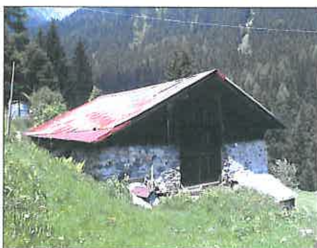
Fronte laterale con accesso al fienile.
