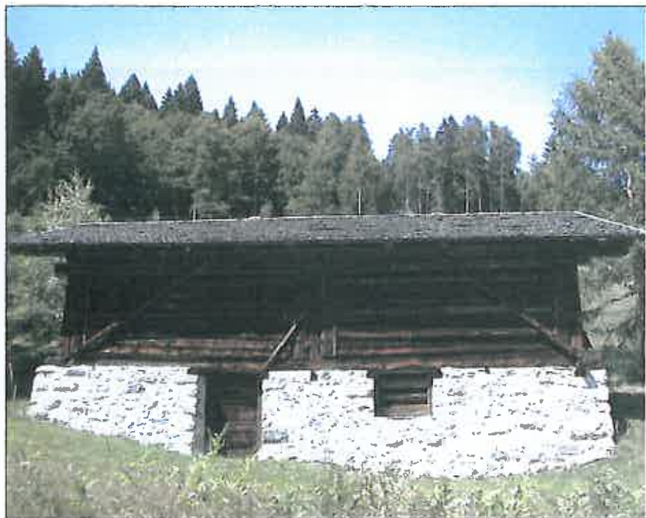
Fronte lato valle: stalla in muratura di pietra e sovrastante fienile in tronchi su telaio di legno.
