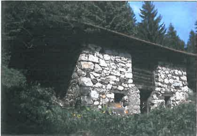
Fronte valle: struttura in cantonali di pietra e tamponamento in tronchi di legno nel fienile. Al piano terra: ingresso e finestre stalla.
