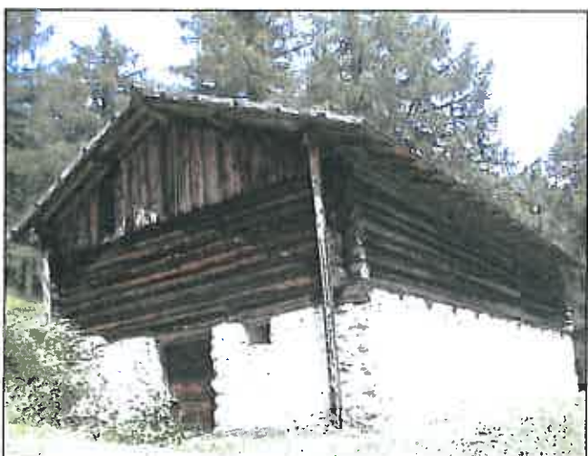
Baita con linea di colmo del tetto parallela al pendio e accesso alla stalla sul fronte laterale; tetto a capriate e terzere con timpano in assi di legno.
