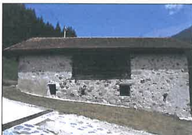
Particolare tamponamento in tronchi di legno al piano fienile.
