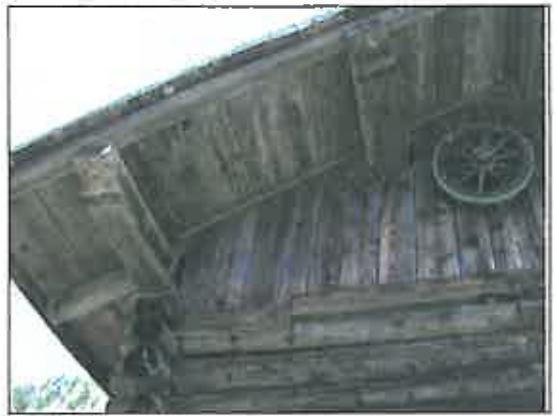
Particolare timpano rivestito di assi verticali.
