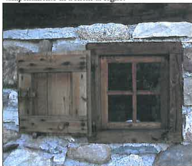
Finestra a riquadri con anta ad oscuro nel basamento in muratura di pietra.
