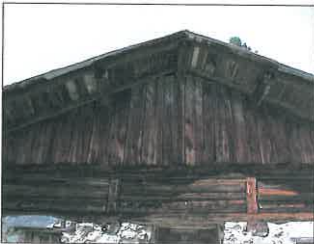
Baita Tipo B - Timpano fronte valle in assi verticali.
