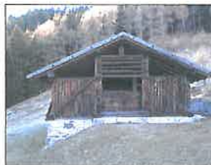
Accesso al fienile sul fronte laterale.
