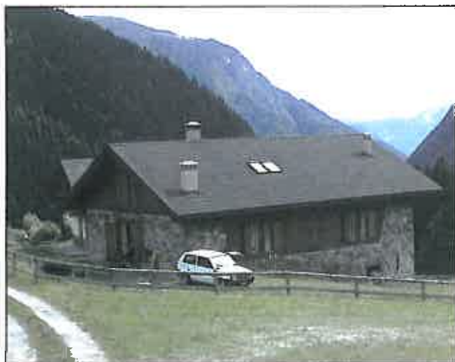
Nuova recinzione nelle pertinenze di baita.
