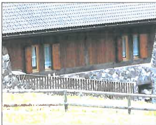
Finestra standard con ante ad oscuro nel tamponamento in assi di legno.
