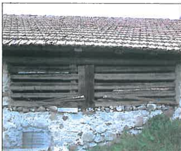
Tamponamento in tronchi di legno orizzontali senza telaio.
