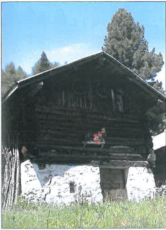
Fronte lato valle: stalla in muratura di pietra e sovrastante fienile in tronchi a incastro.
