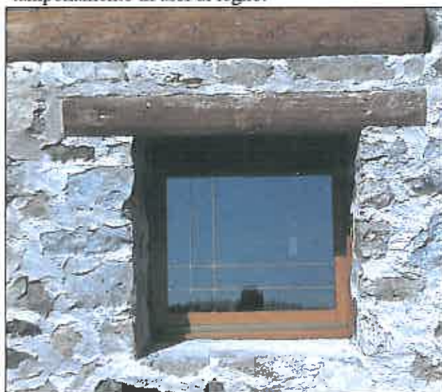
Finestra con vetro profilato in ottone nel basamento in muratura di pietra.
