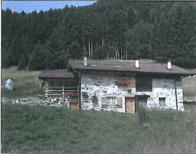
Aggiunta di corpo laterale; ampliamento foro esistente e aggiunta nuovo foro nel tamponamento.
