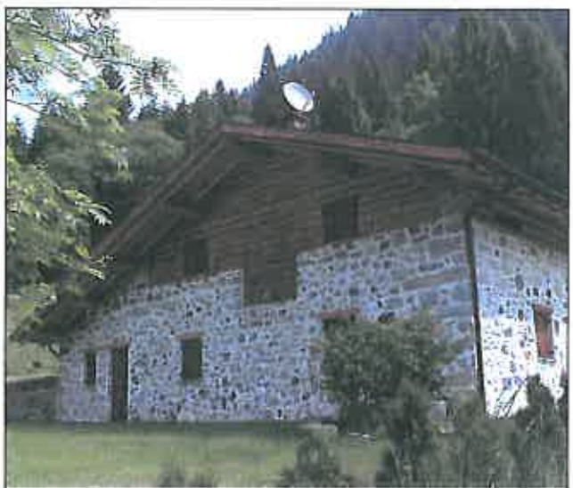
Aggiunta di corpo laterale. Modifica pareti in muratura di pietra, tamponamenti di legno, fori e tetto.
