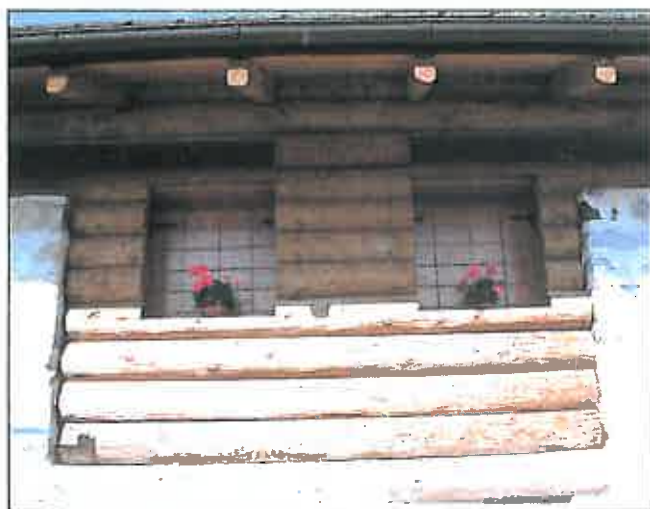
Finestre standard con ante ad oscuro nel tamponamento in tronchi di legno.
