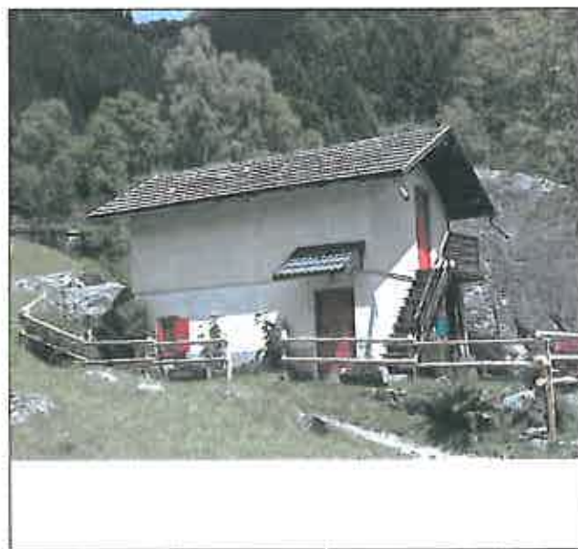
Aggiunta di scala esterna e tettoia d'ingresso. Eliminazione parti lignee e intonacatura civile di muri in pietra. Tinteggiatura dei serramenti.
