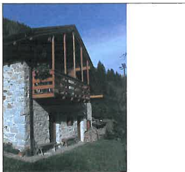
Inserimento di poggiolo sul fronte principale.
